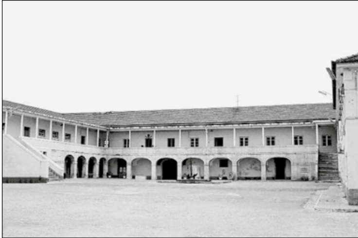
Figura 21 - Vale de Zebro: Escola Prática de Torpedos e Electricidade (1902-1934), hoje Escola de Fuzileiros 465
