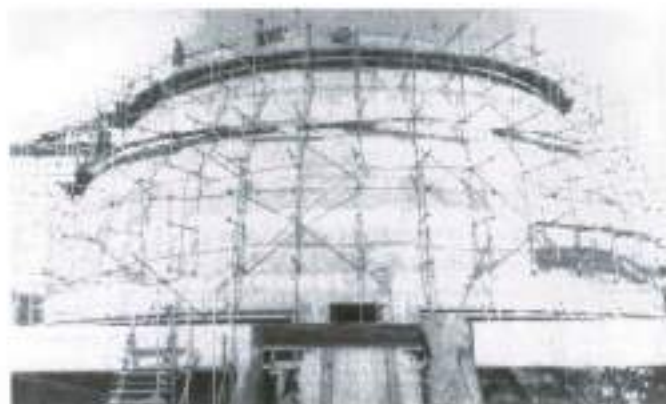
Figura 5 — Construção do Planetário Calouste Gulbenkian
