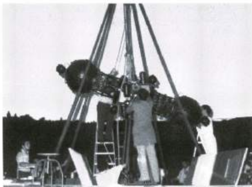
Figura 7 — Reparação periódica do equipamento
