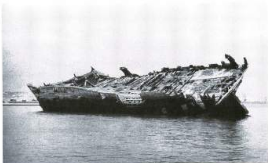
O que restou após o incêndio
