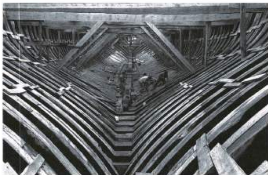
Recuperação do porão
