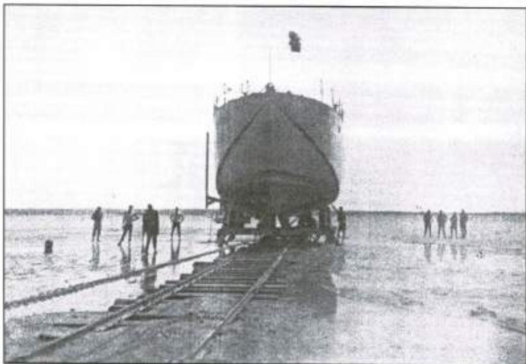
Troço de linha férrea lançada sobre a praia, no Lumbo.
