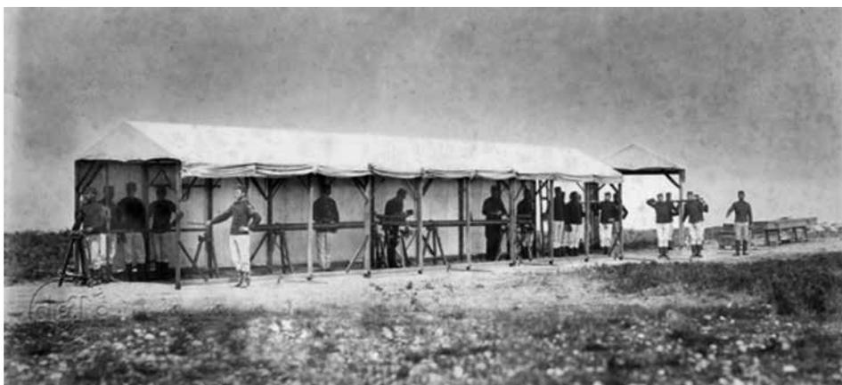
Figura 11 – Imagem ilustrativa dado processo de medição de uma base, com réguas calibradas semelhantes às usadas por Francisco Ciera. A medição das bases era a operação mais delicada e crítica, visto que os erros cometidos reflectir-se-iam directamente em todos os cálculos dos comprimentos. (Fonte: Imagem cedida pela Direcção Geral do Território).
