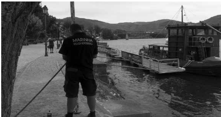
Nivelamento geométrico no Pinhão.
